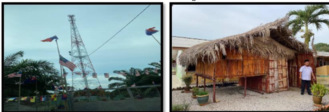
Gambar 12: Pencawang telekomunikasi Kampung Sungai Mering dan rumah contoh tradisi Orang Asli Temuan di Sekolah Kebangsaan Asahan
